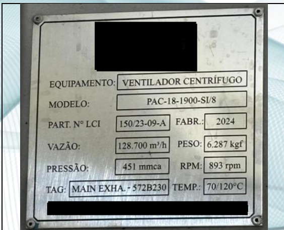
Placa Identificação Exaustor
